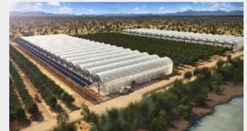
Des serres agricoles arrosées à l'eau de mer.
